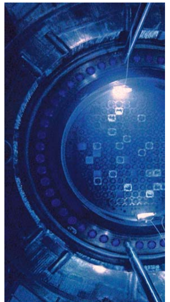
Blick in den Reaktorkern eines Kernkraftwerks: Dort werden die Brennelemente eingesetzt.
