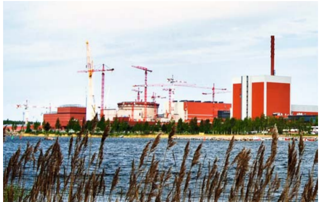
Gerade im Bau: der EPR-Reaktor im finnischen Olkiluoto.
