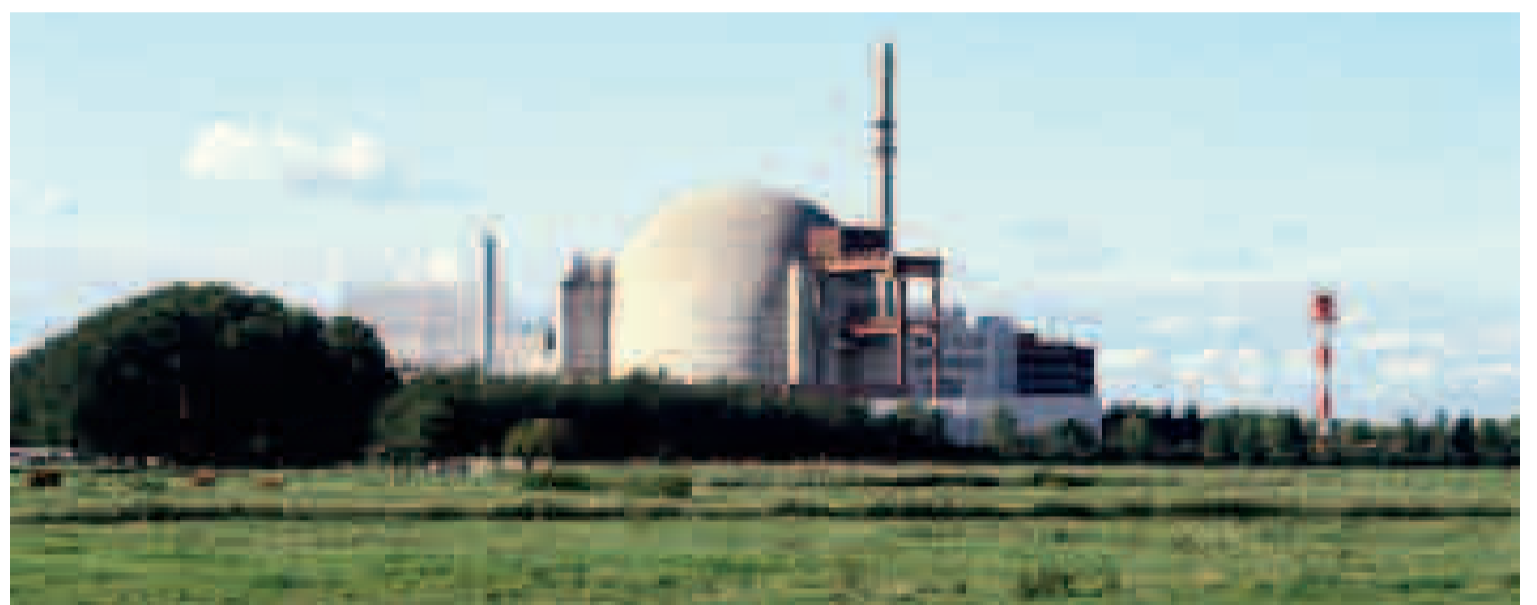
Nach der Entscheidung der Bundesregierung wird das KBR bis 2021 am Netz bleiben.
