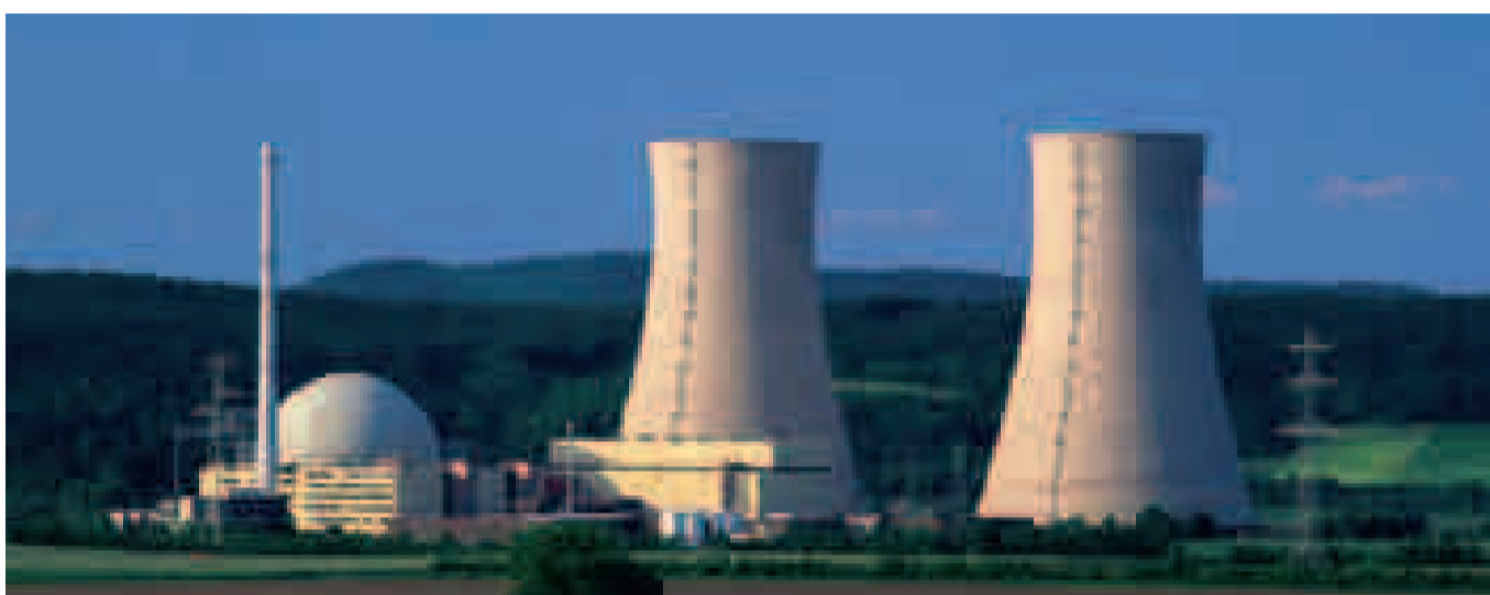
Nach der Entscheidung der Bundesregierung wird das Gemeinschaftskernkraftwerk Grohnde (KWG) bis 2021 am Netz bleiben.
