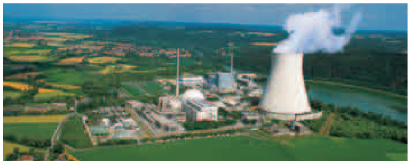
Nach der Entscheidung der Bundesregierung wird das KKI2 bis 2022 am Netz bleiben. Das KKI1 (graues Gebäude, rechts hinten im Bild) ist seit 17. März abgeschaltet.
